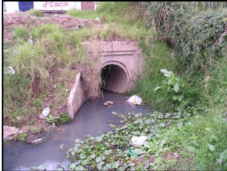
Figura 8.4.1.1. Alcantarilla-Sumidero de Ingreso al Colector Pluvial
