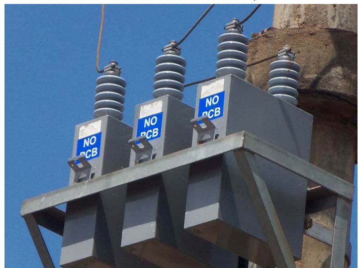
Detalles que muestra la estructura metálica que soporta el banco capacitivo por encima se observa los seccionadores fusibles bajo carga
