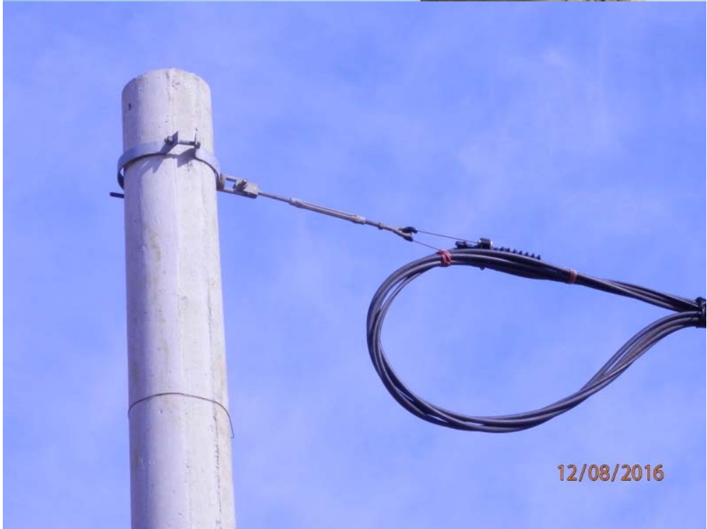
Columna HºAº retención con un tensor SRC1T
