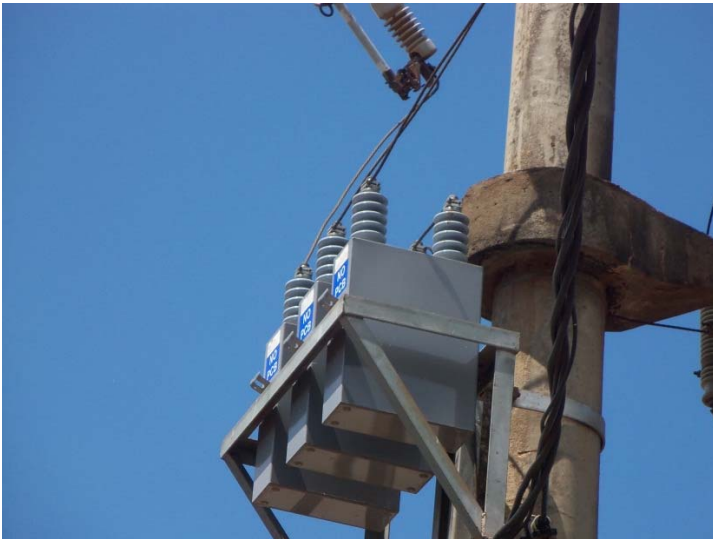
Detalles que muestra la estructura metálica que soporta el banco capacitivo por encima se observa los seccionadores fusibles bajo carga
