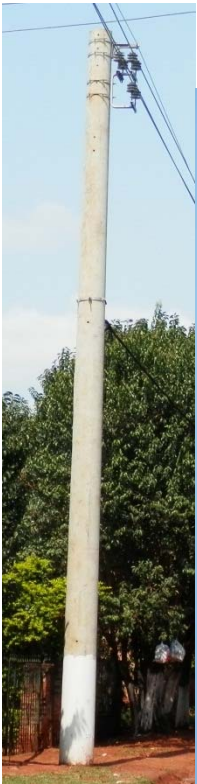
Columna HªAª SOSTEN SIMPLE, para conductor de media tensión protegido con doble soporte aislador por línea para cruce de calle y otros SS
