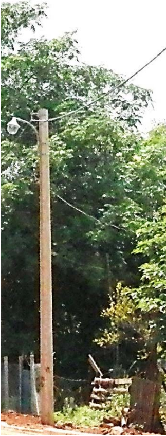
Columna HªAº Suspensión simple con alumbrado público SSCBN
