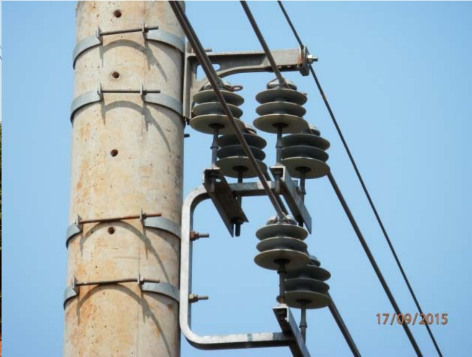
Columna HªAª SOSTEN SIMPLE, para conductor de media tensión protegido con doble soporte aislador por línea para cruce de calle y otros SS
