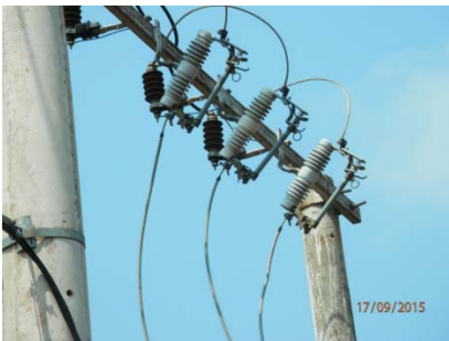
Detalle cruzeta de PERFIL HIERRO con sus descargadores atmosférico protegida Y los seccionadores fusibles bajo carga Subestación convencional RETENCIÓN para línea protegido aislación XLPE PARA 13,2 KV
