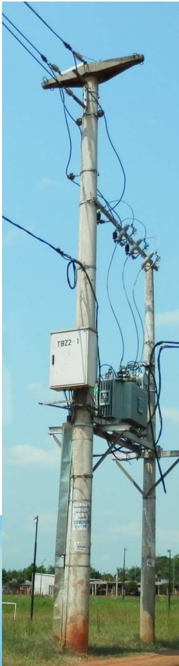
Detalle cruzeta de PERFIL HIERRO con sus descargadores atmosférico protegida Y los seccionadores fusibles bajo carga Subestación convencional RETENCIÓN para línea protegido aislación XLPE PARA 13,2 KV
