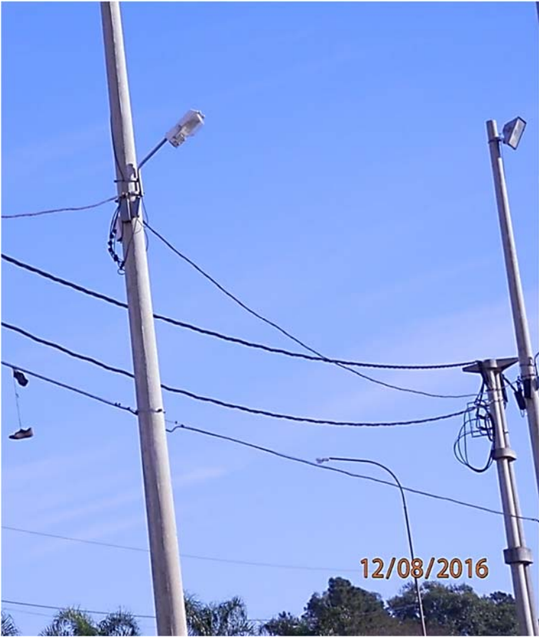
Illuminación con proyector de Hg halogenado y lámparas de Sodio Alta Presión como luz de Alumbrado público para cancha de futbol
