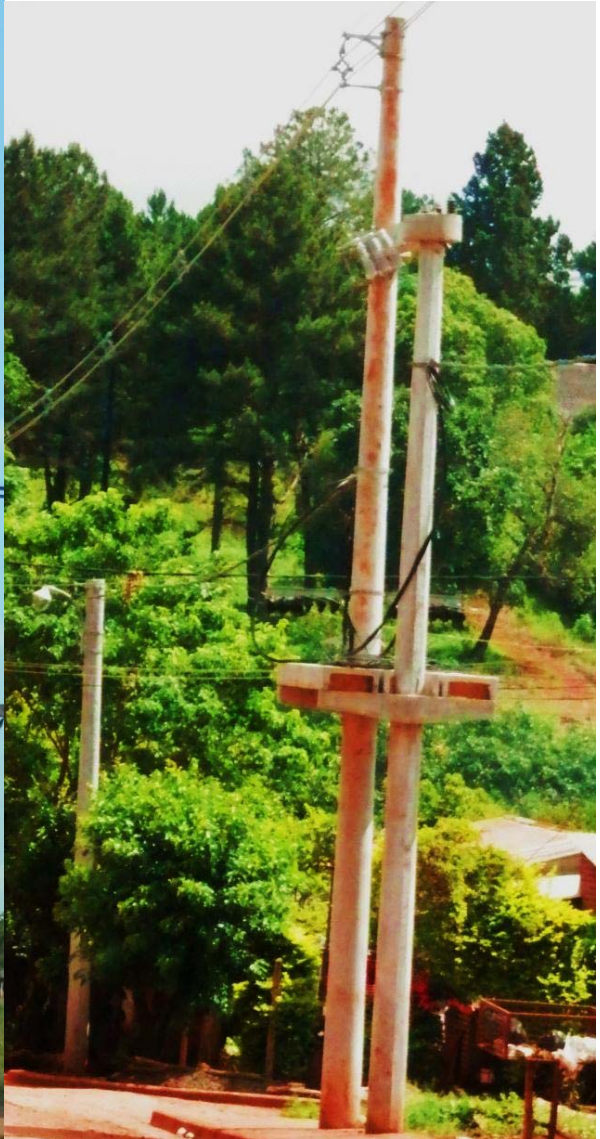
Estructura subestación PASANTE para Línea
