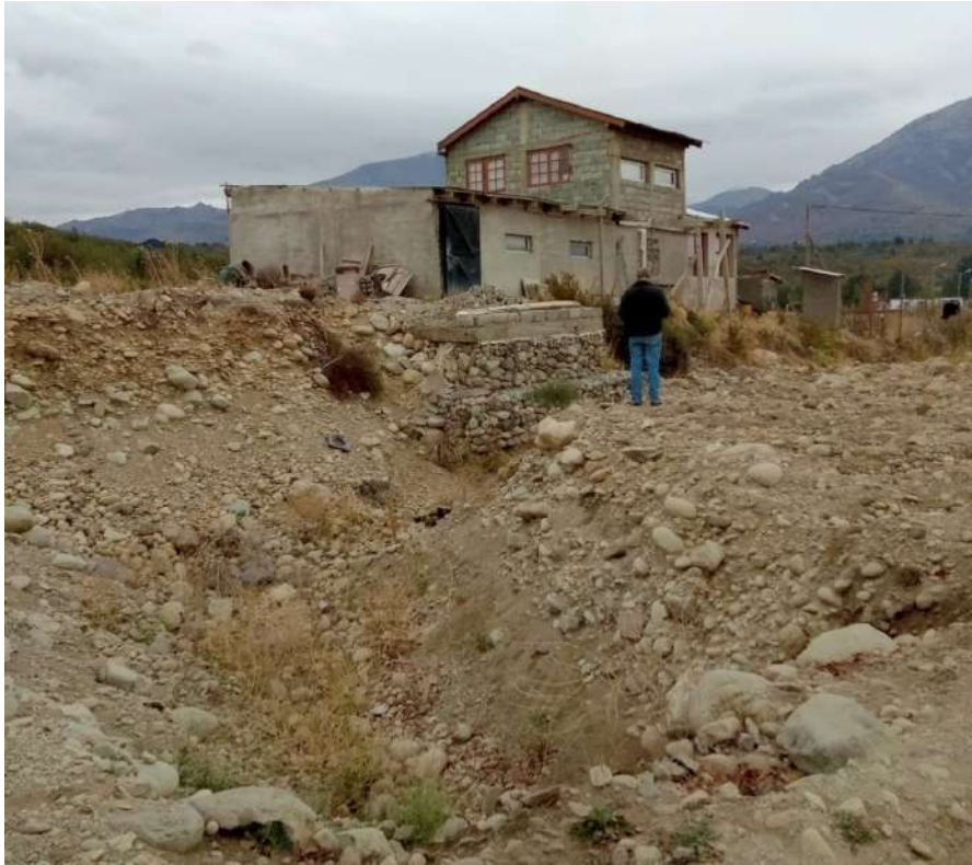
Imagen 1: Canal pluvial existente aledaño a la vivienda estabilizada mediante gaviones. Calle Hoyo de Epuyén y Magnolias.
