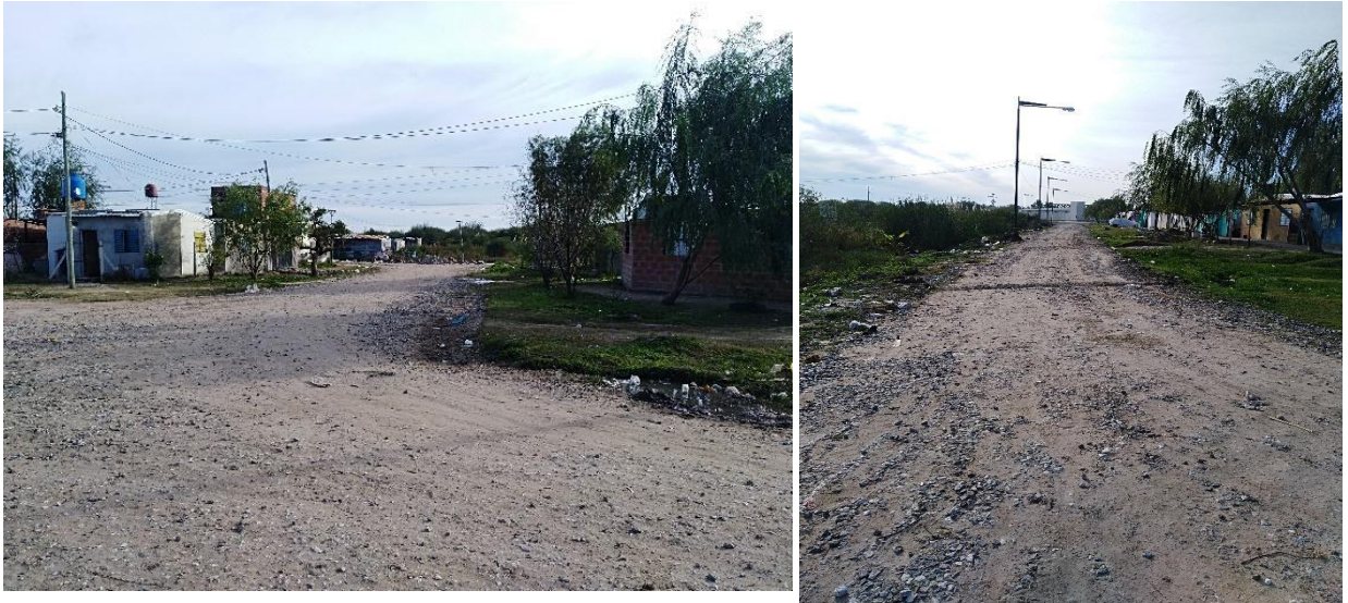
Foto 35: calle Azopardo (mira al norte). Foto 36: calle secundaria entre Padre Quiroga y Aguado (mira al este).
