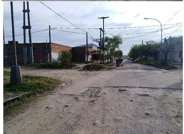
Fotos 12, 13, 14 y 15: Intersección calles Aguado y Vera. Falta finalización de pavimento y cordón cuneta en esquinas.
