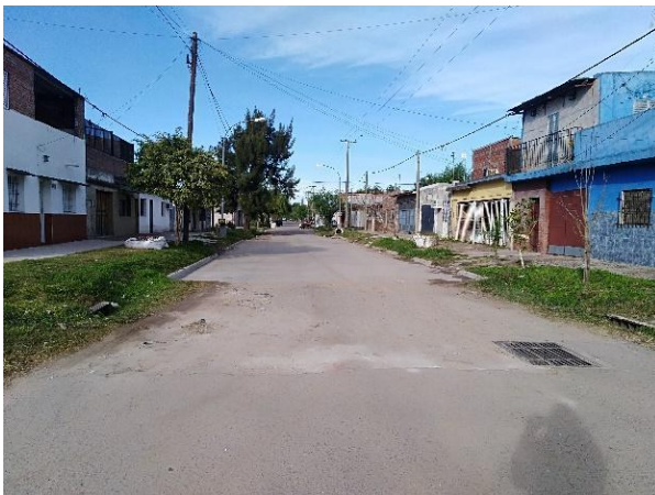
Fotos 12, 13, 14 y 15: Intersección calles Aguado y Vera. Falta finalización de pavimento y cordón cuneta en esquinas.
