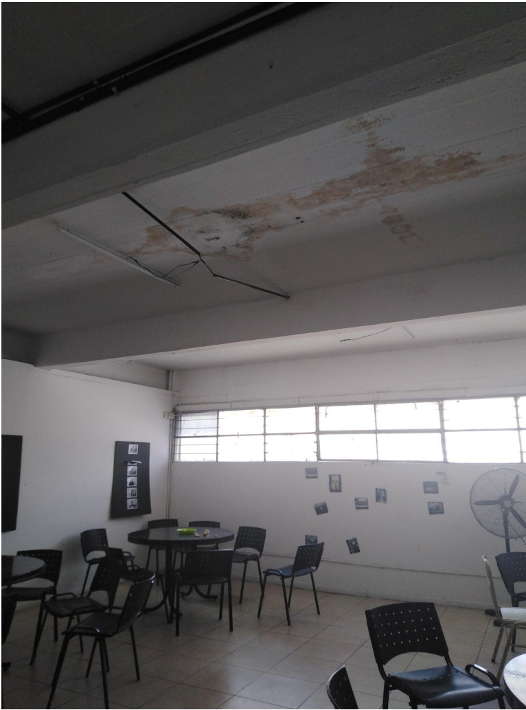
Ilustración 8: imagen interior – comedor/ S.U.M.
